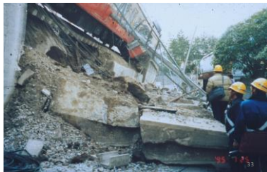
石屋川駅付近重力式擁壁の被災状況
